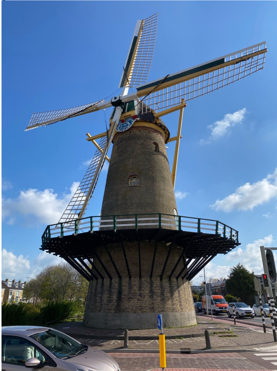
Molen de Vier Winden na restauratie van de wieken in 2021
